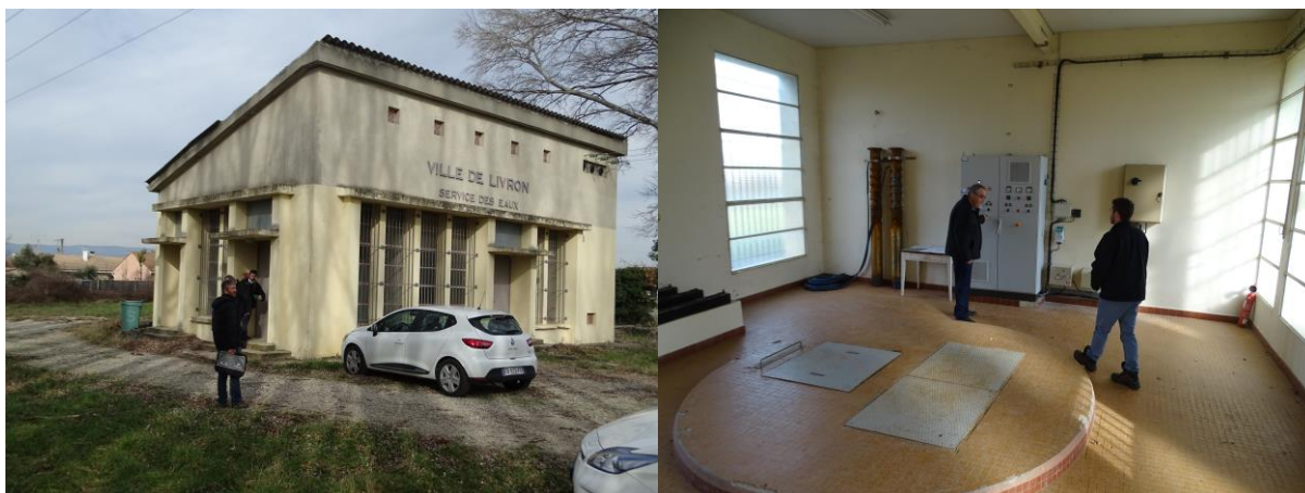
Le bâtiment abritant les installations et le local de service
